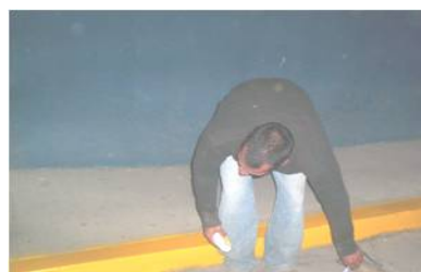
5. TRABAJOS DE SEÑALIZACIÓN HORIZONTAL
