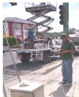
5. TRABAJOS DE SEMAFORIZACIÓN
