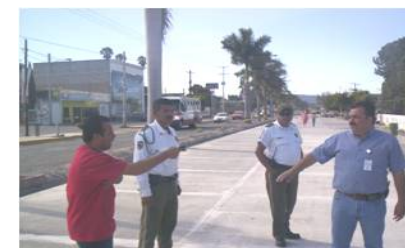
6. APOYO VIAL EN TRABAJOS DEL BLVD. TEP-XAL
