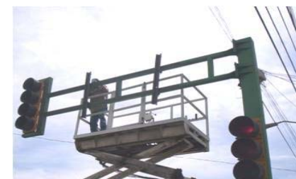
6. MANTENIMIENTO A SEMÁFOROS
